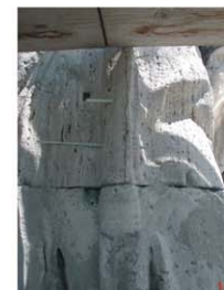
12/15 - Immagini fotografiche delle fasi di consolidamento delle statue attraverso barre in vetroresina, inserite in posizione incrociata (previo foratura del travertino con microtrapani) e fissate con resina.
